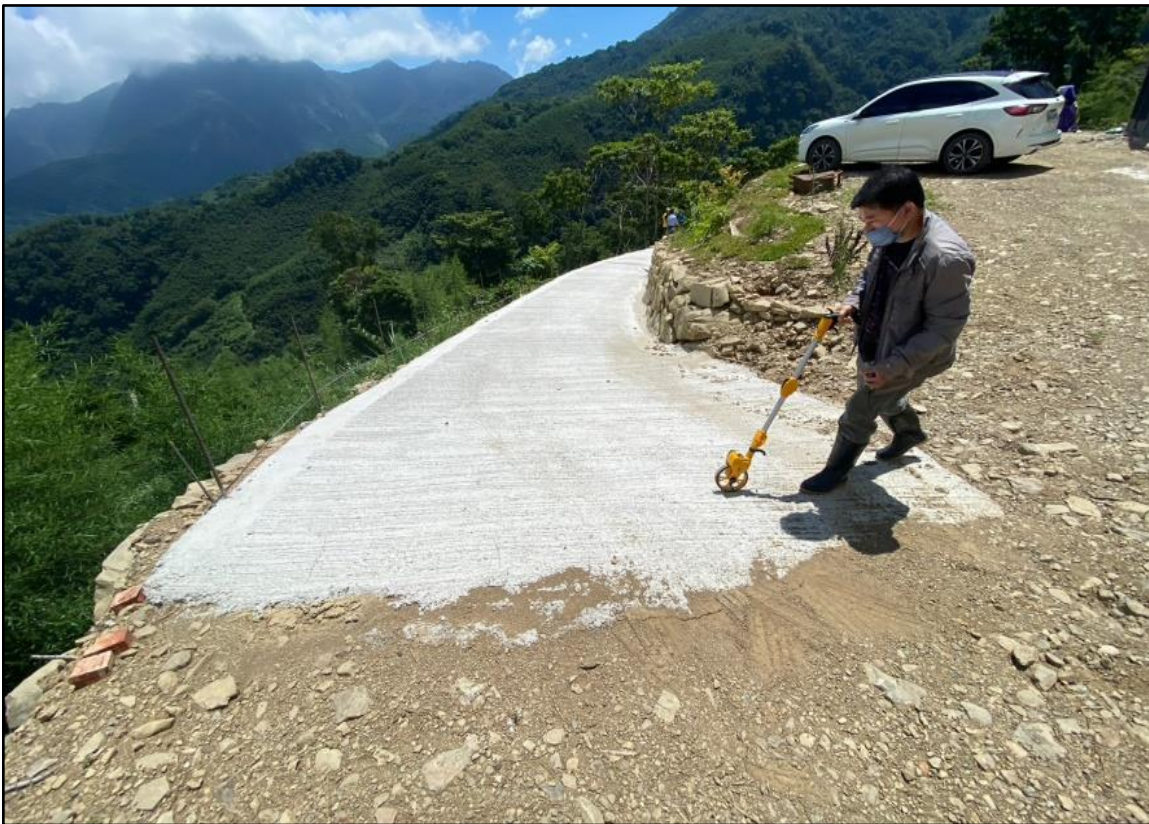
附圖2、現場量測農路長度82公尺，寬度2.7~5.4公尺 資料來源：新竹縣政府提供
