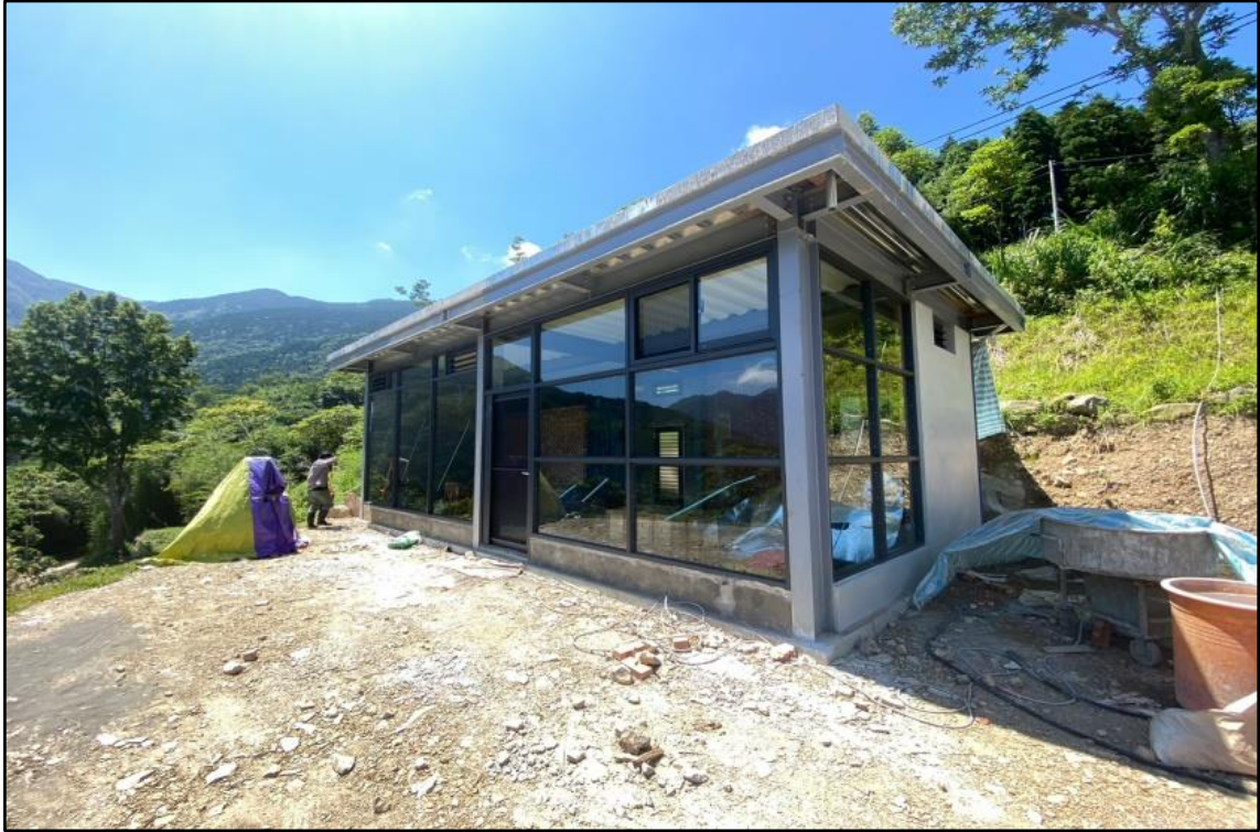
附圖1、現場量測資材室寬度9.18公尺、深度5.13公尺 資料來源：新竹縣政府提供
