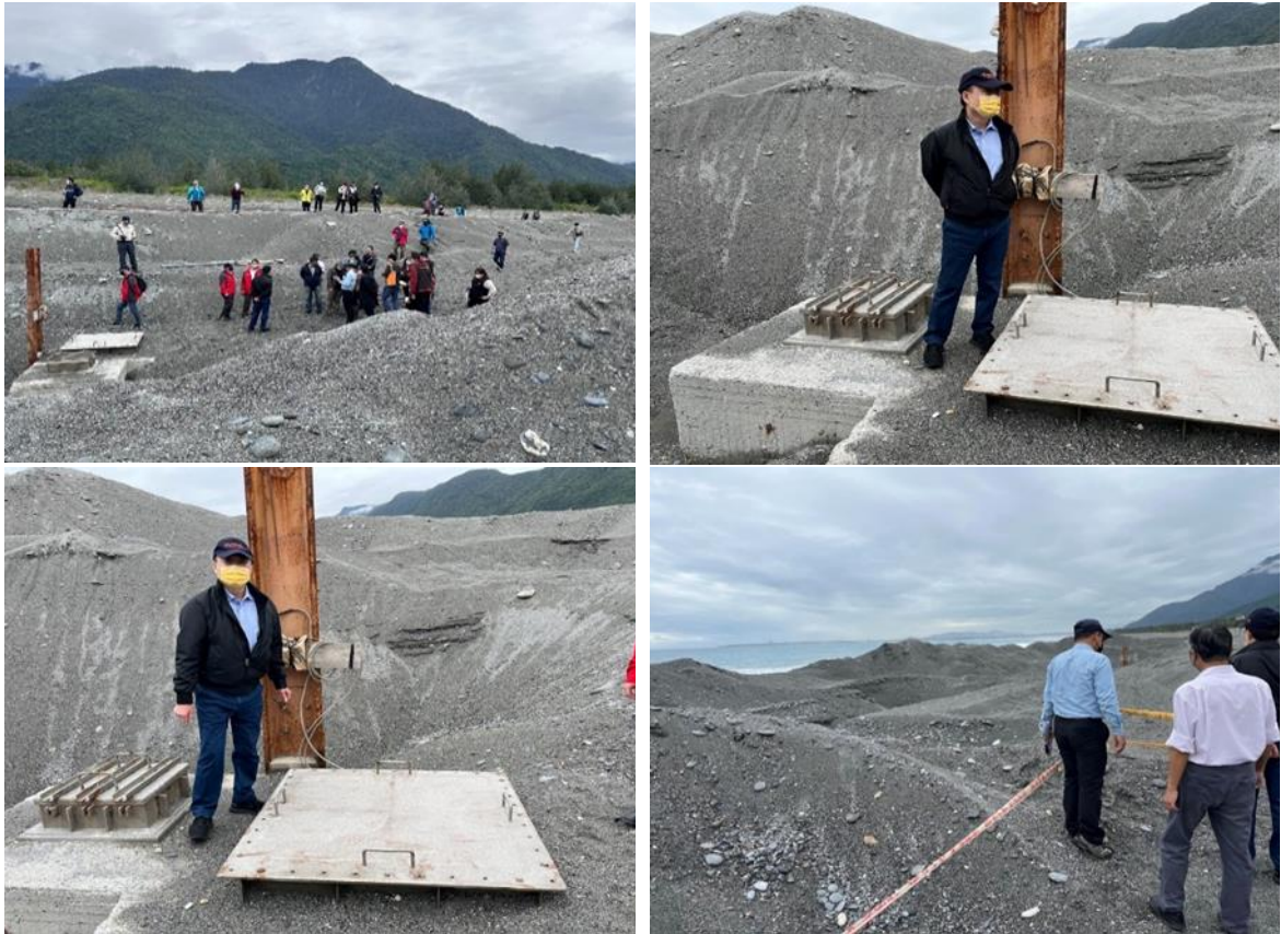
圖1、本院發現新城鄉未登錄海岸土地遭開挖鋪水泥及取用深層海水，暫以黃色警示線圈圍起來。
