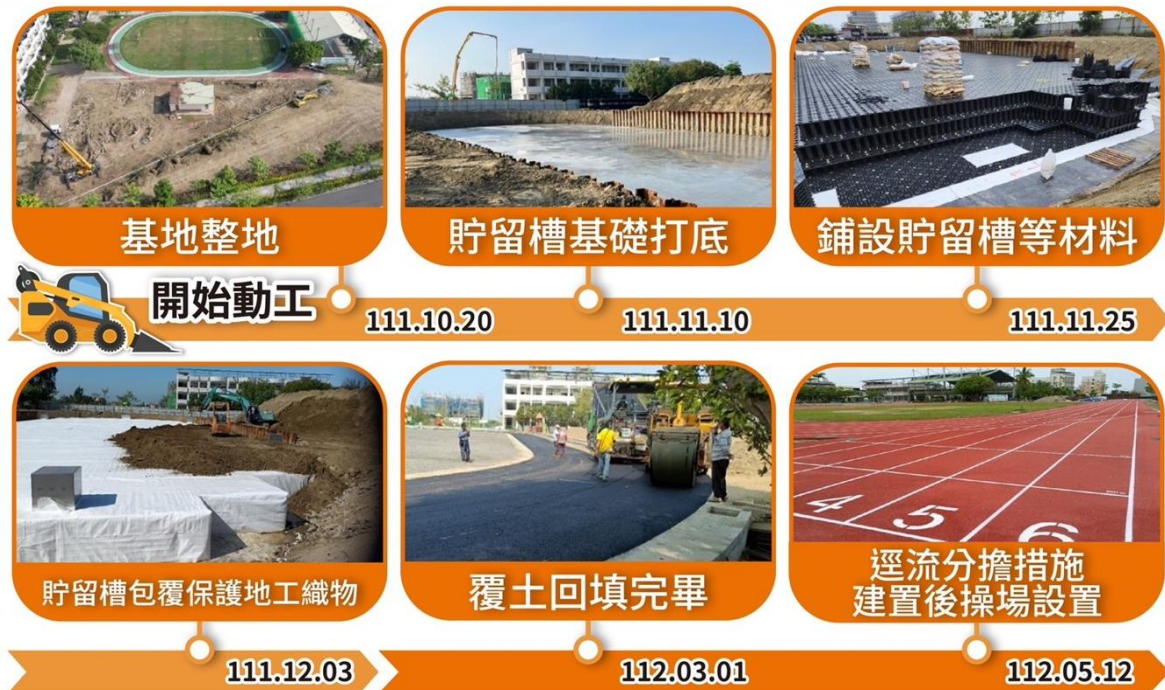
圖4 安佃國小逕流分擔施工過程
