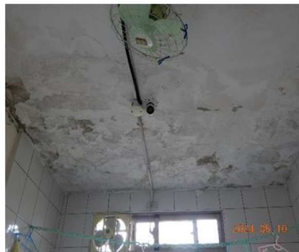
照片2 勵志中學牆面剝落及壁癌情形
