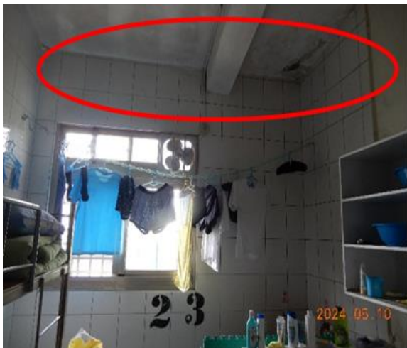
照片2 勵志中學牆面剝落及壁癌情形
