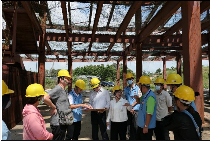
圖1 工區 Villa 式渡假旅館鋼骨結構現況，本院112年9月27日攝。
