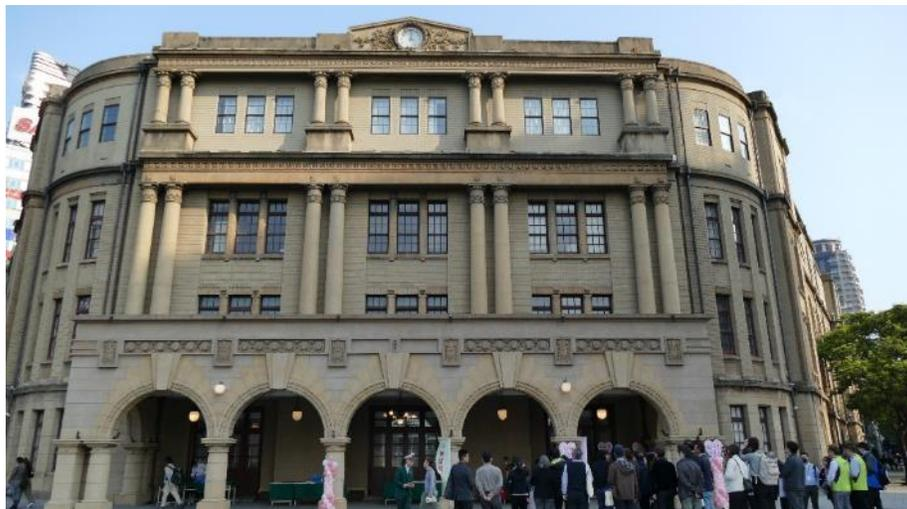
位於臺北市中正區。日治昭和時代(西元1930年)竣工，由栗山俊一設計，運用古典建築語彙融合現代建築折衷式樣，為三層樓水泥鋼骨(SRC)構造。建物形式不脫西洋古典建築仿希臘山牆、科林斯柱式及仿羅馬拱券三段立面的色彩，又具備現代建築物的簡潔精神。建物大廳留出二層樓之高度，精細的天花板及柱頭，予人華貴莊重的印象
