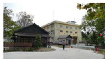
遊客服務中心+修理工廠
