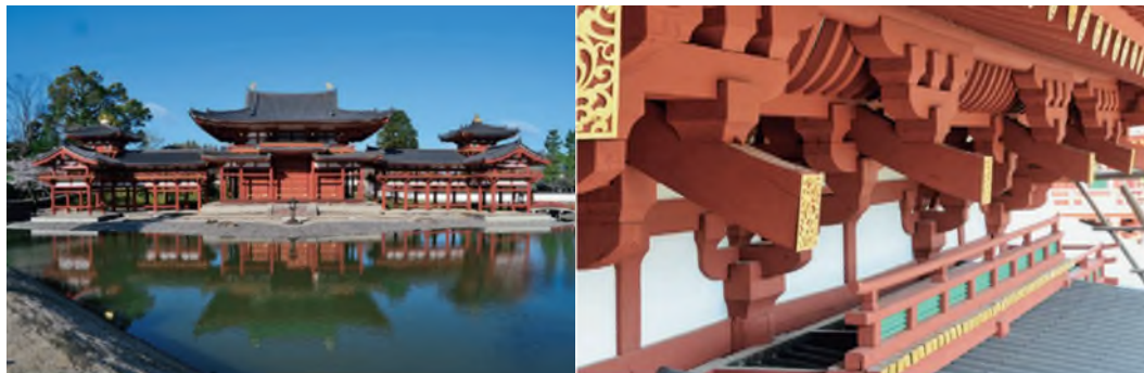
鳳凰堂修整後
