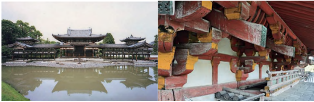
鳳凰堂修整前
