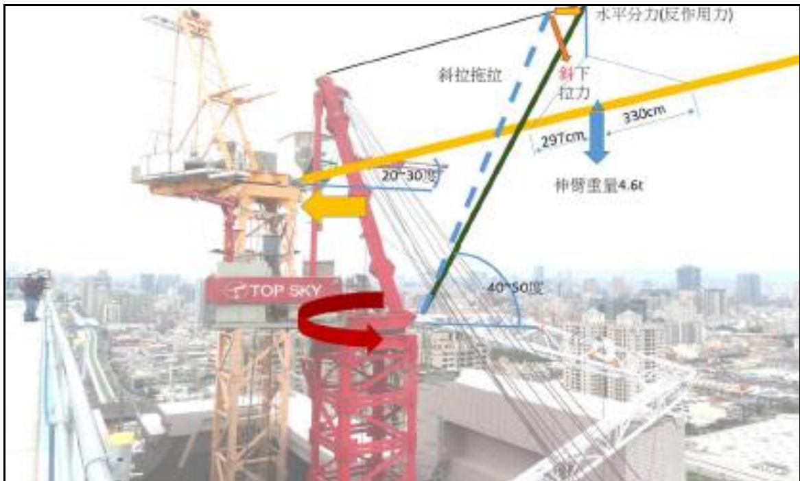
圖15 拆除機吊臂受力圖
