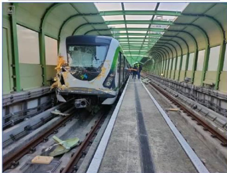
圖2 事故列車車頭撞擊塔式起重機桁架後毀損
