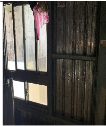
頂樓加蓋5樓。無空調。
