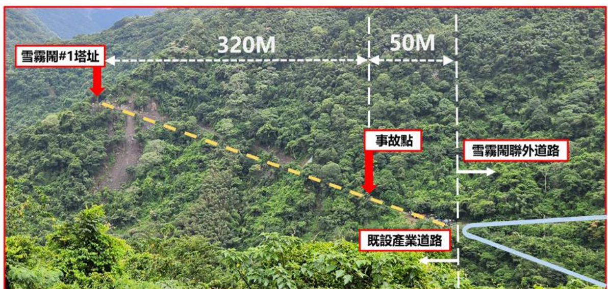
圖2 台電公司北區施工處外包廠商112年8月3日「巴陵配電桿線改建輸電鐵塔工程」4死2傷之重大災害案示意圖
