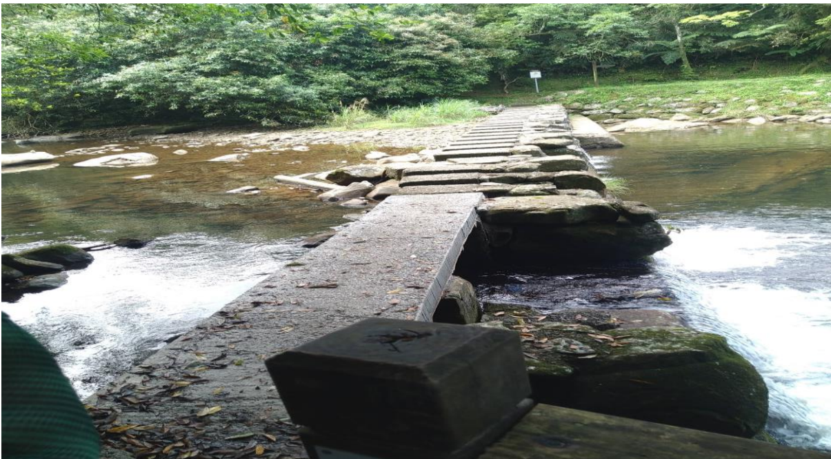
圖1 事發前虎豹潭跨溪石墩（石跳仔）【即報載梳子壩】
