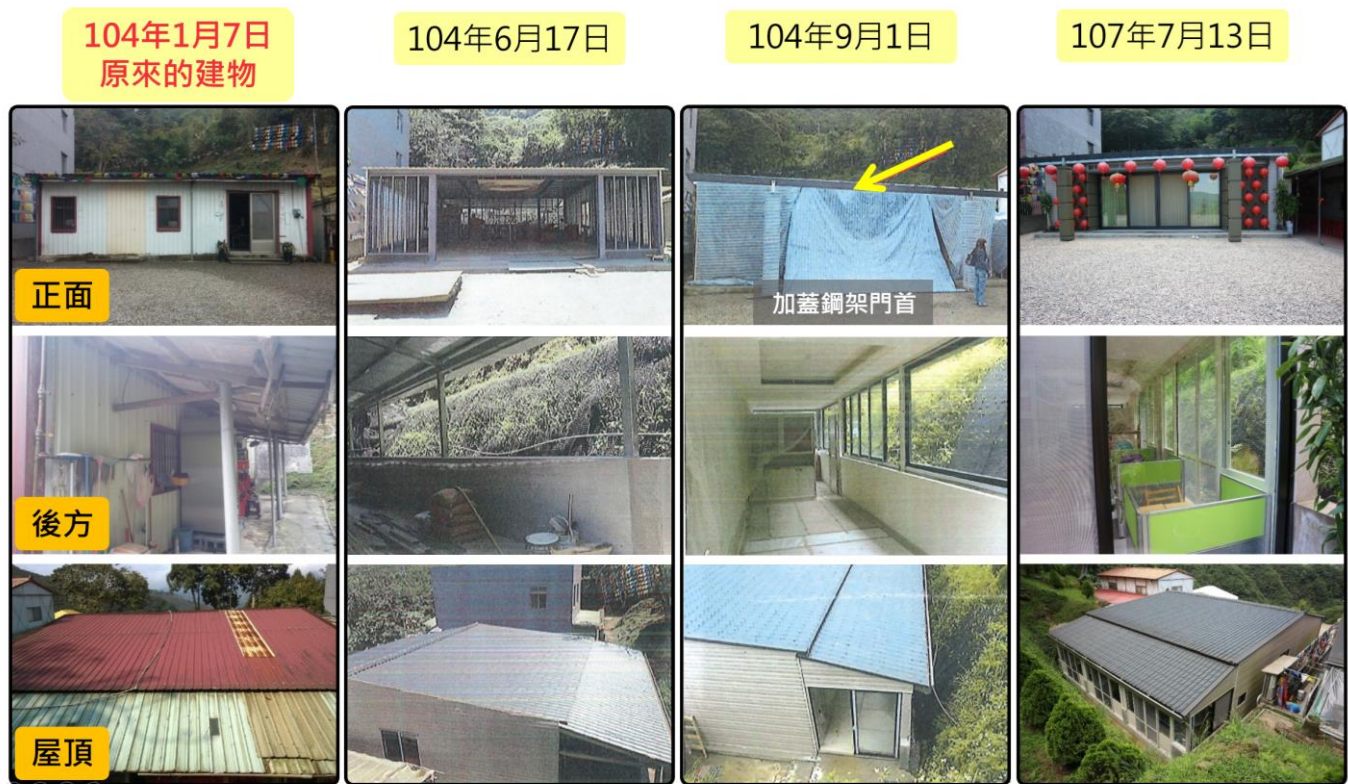
圖1 本案建物修繕（建）施工前後對比圖（一）
