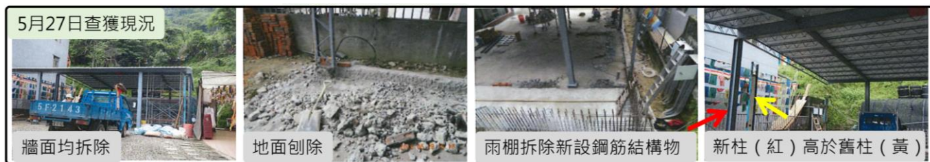
圖2 本案建物修繕（建）施工前後對比圖（二）
