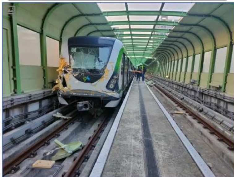
圖2 事故列車車頭撞擊塔式起重機桁架後毀損
