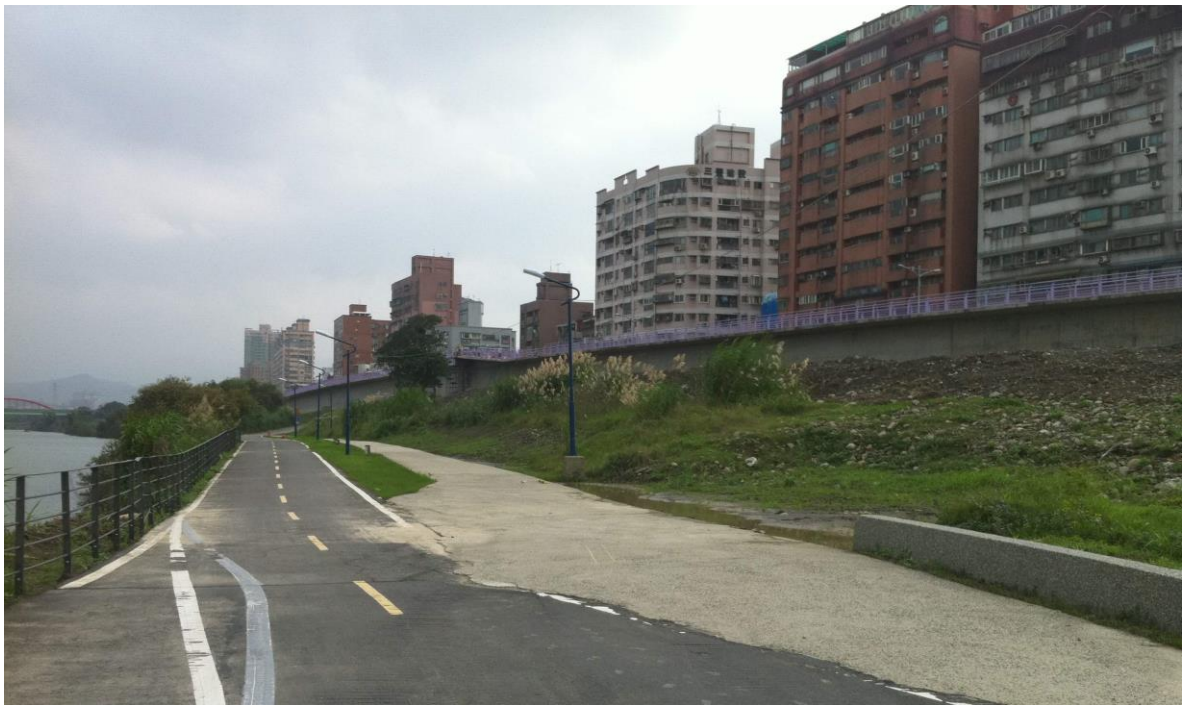
附圖六、非屬工程範圍閒置待用土地 資料來源：本院現場履勘照片
