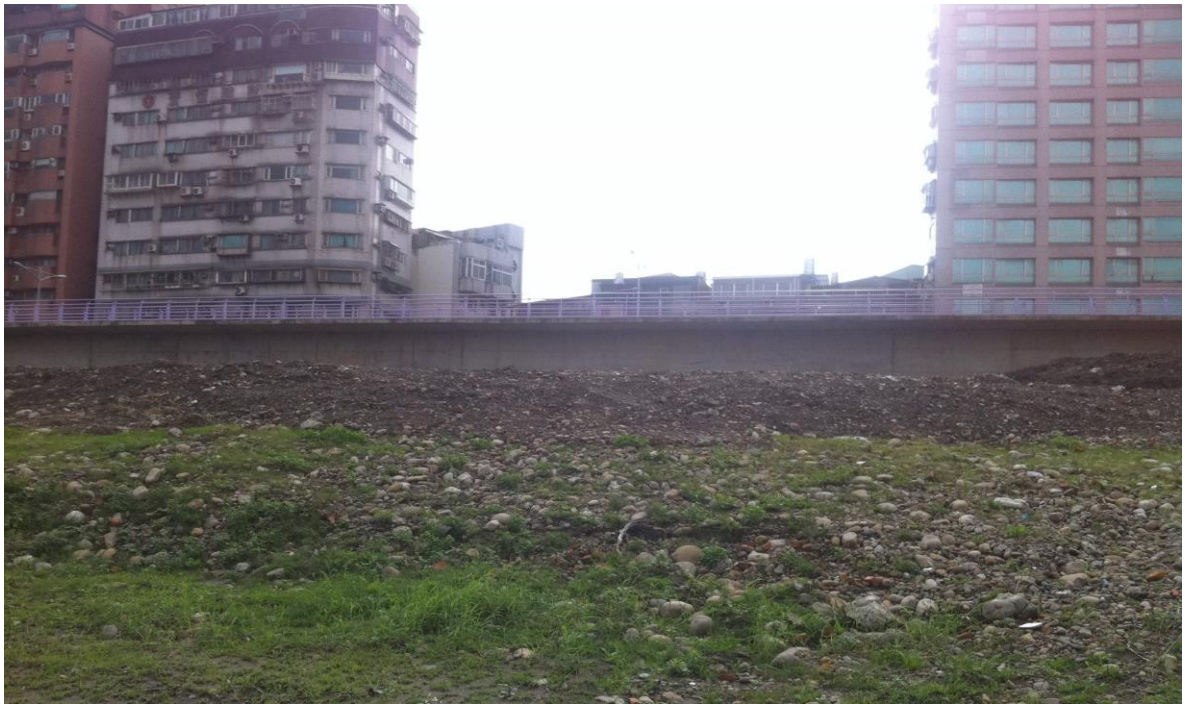
附圖七、徵收範圍營建署施工中未能施作土地 資料來源：本院現場履勘照片
