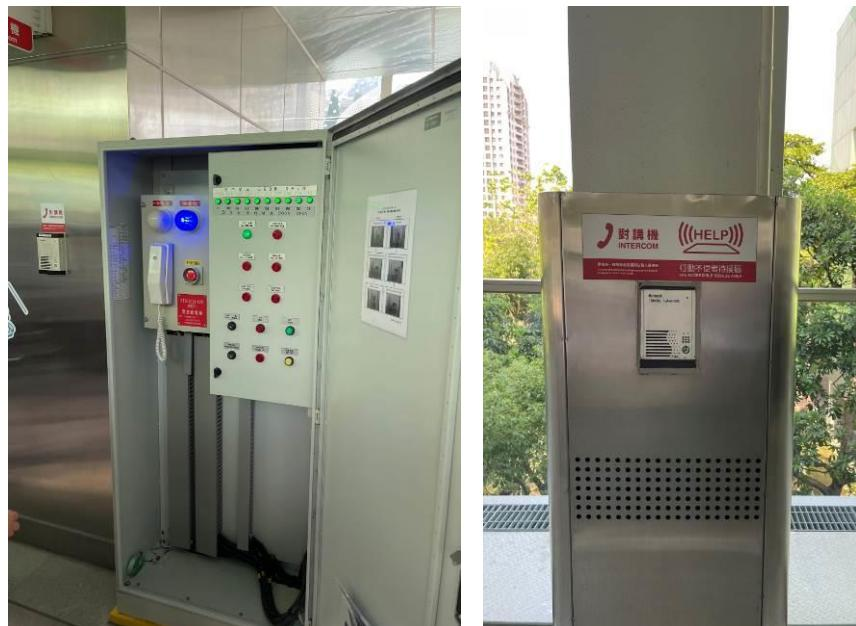
照片6 月台門控制盤上鎖箱體內緊急斷電設備(左)、月台對講機(右)
