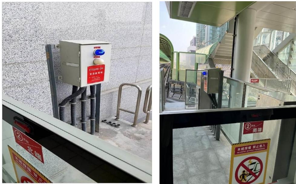
照片5 月台端牆門外方緊急斷電設備
