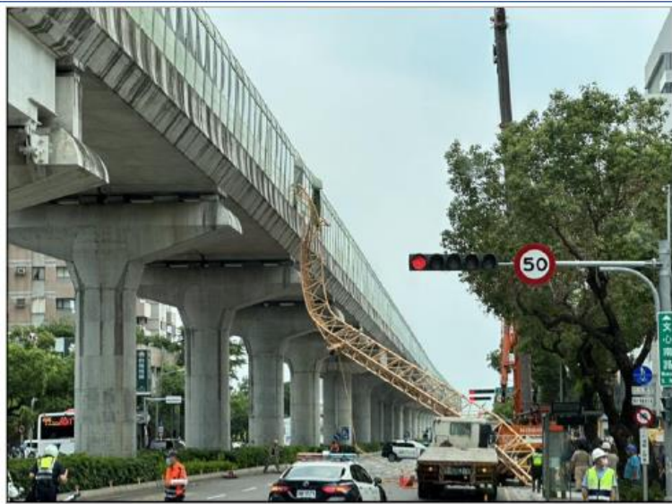
圖1 斷裂墜落之桁架侵入捷運路線
