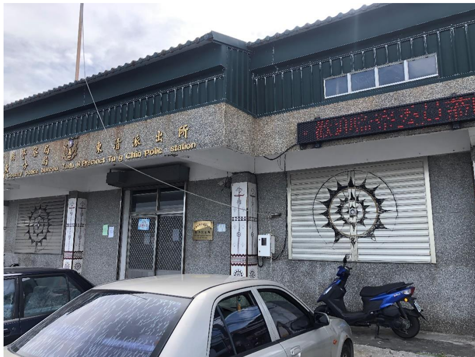
圖13 環境輻射監測站
