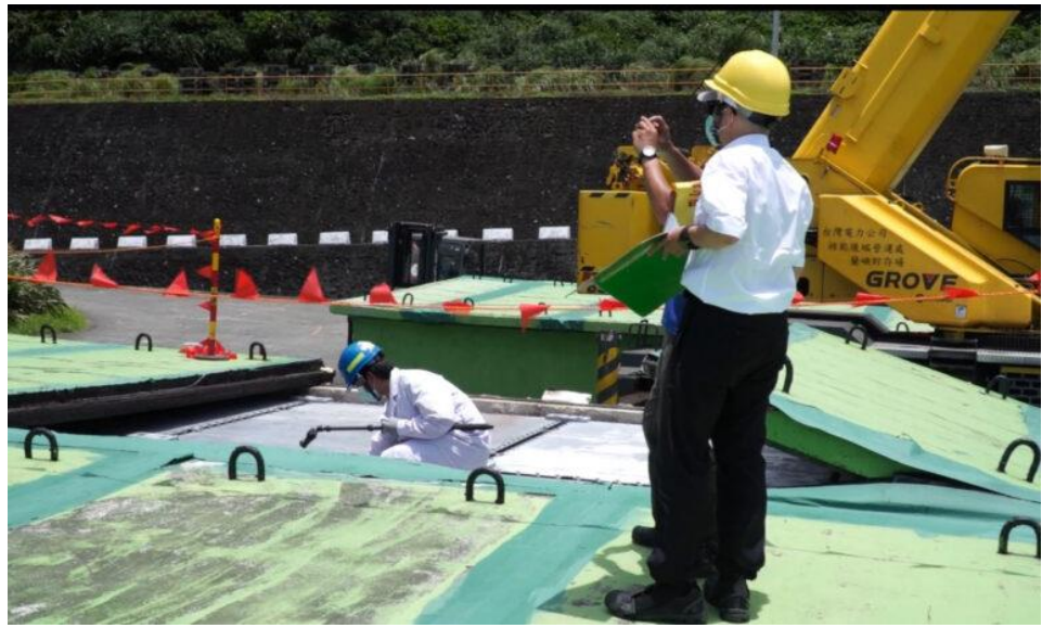
圖4 本院勘查壕溝內貯存狀況
