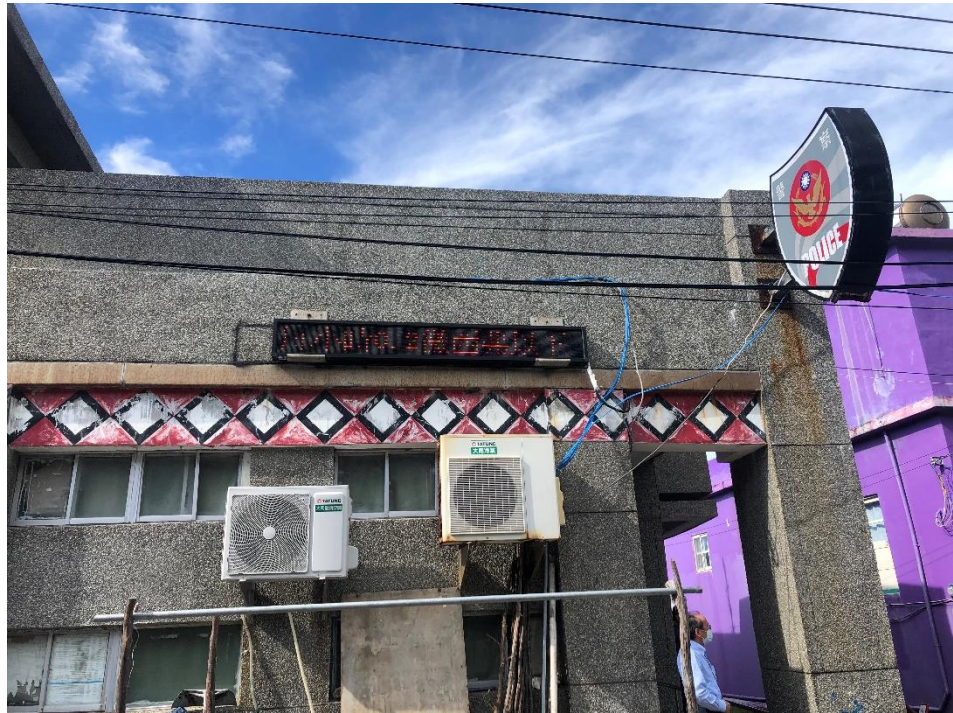
圖14 環境輻射監測站
