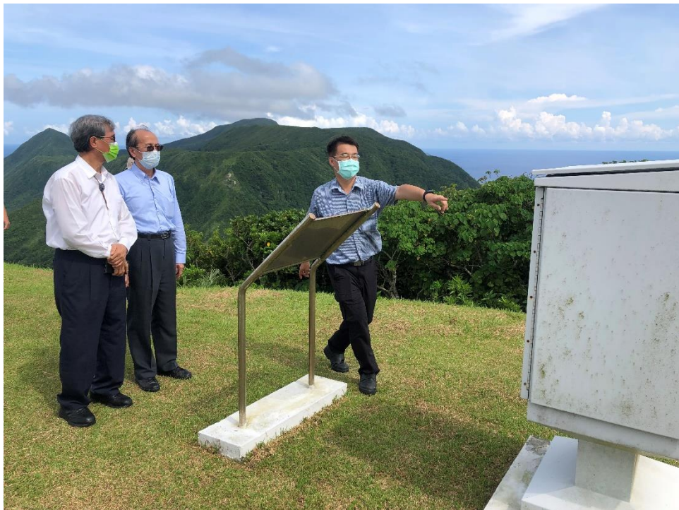
圖11 環境輻射監測站
