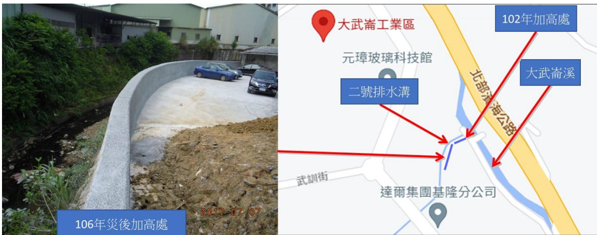
(b) 六二水災後完成施作之區段（資料來源：基隆市政府簡報）
