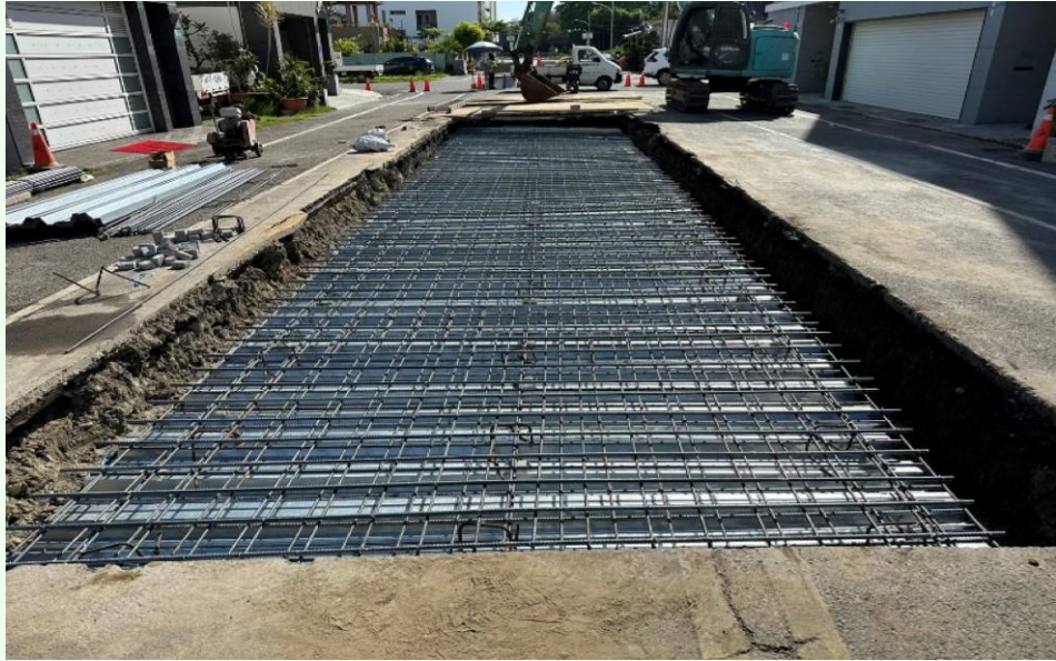
圖2 雨水箱涵頂版修繕
