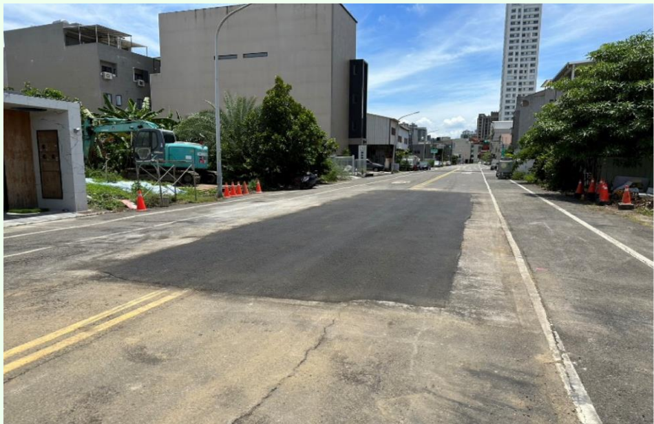
圖3 完成鋪設瀝青混凝土路面
