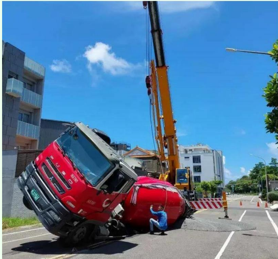
圖1 府平路555號前大型混攪拌車陷入坑洞
