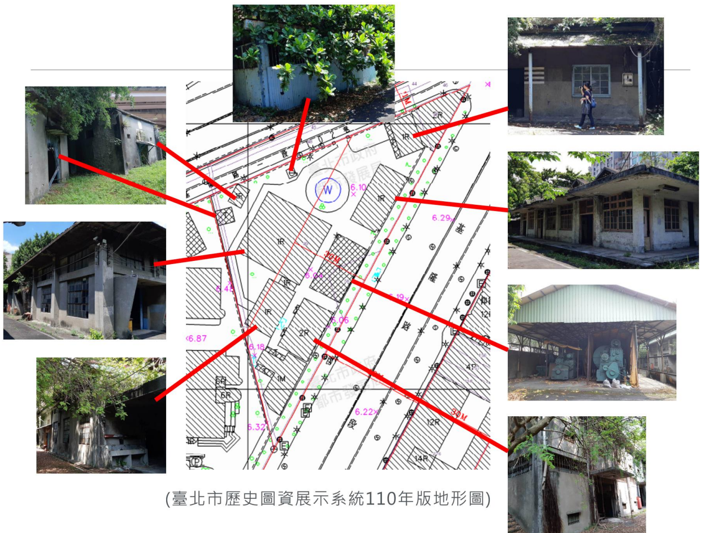
圖4 原臺鐵臺北機廠造漆工場現況構造物照片(呈廢棄狀態) 資料來源：臺鐵局112年3月2日提供
