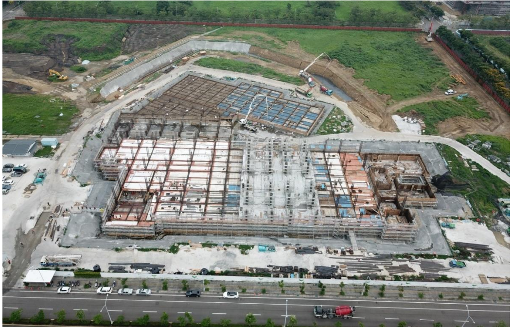
圖4 建築結構地下室頂版(1樓底版)施工階段空拍照圖
