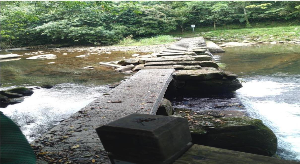
註：事發後石墩上木板已滅失，新北市雙溪區公所改鋪設水泥混凝土板塊。
