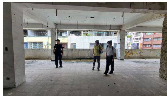
系爭不動產其他樓層內部現況
