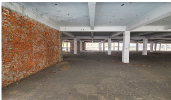
系爭不動產其他樓層內部現況
