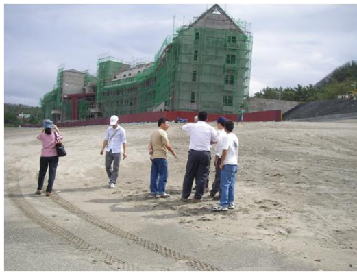
圖4 美麗灣拓建既有鋪面，新增之駁坎已連接至建物第2層
