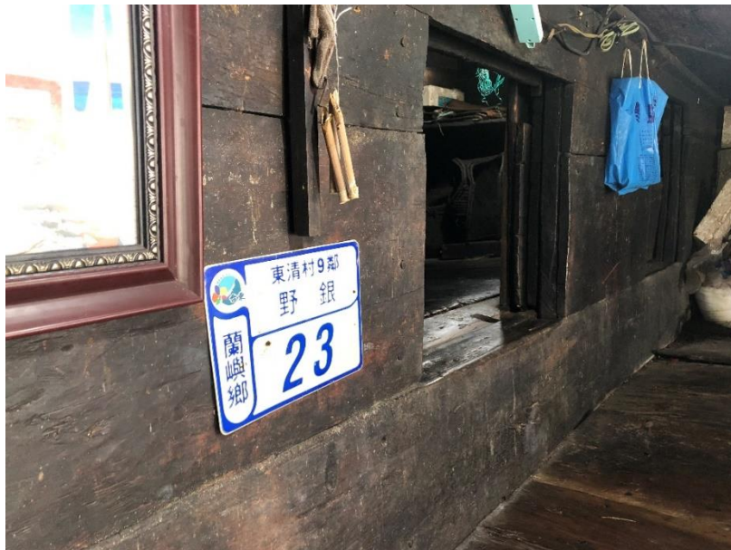
圖9 蘭嶼野銀部落地下屋保存情形
