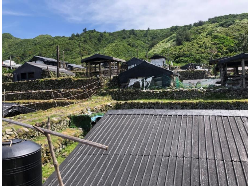
圖8 蘭嶼野銀部落地下屋現況
