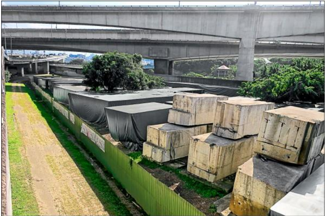
圖 7 中山橋(明治橋)拆成石塊 30
