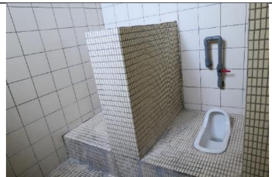
勇班教室黑板處後方廁所
