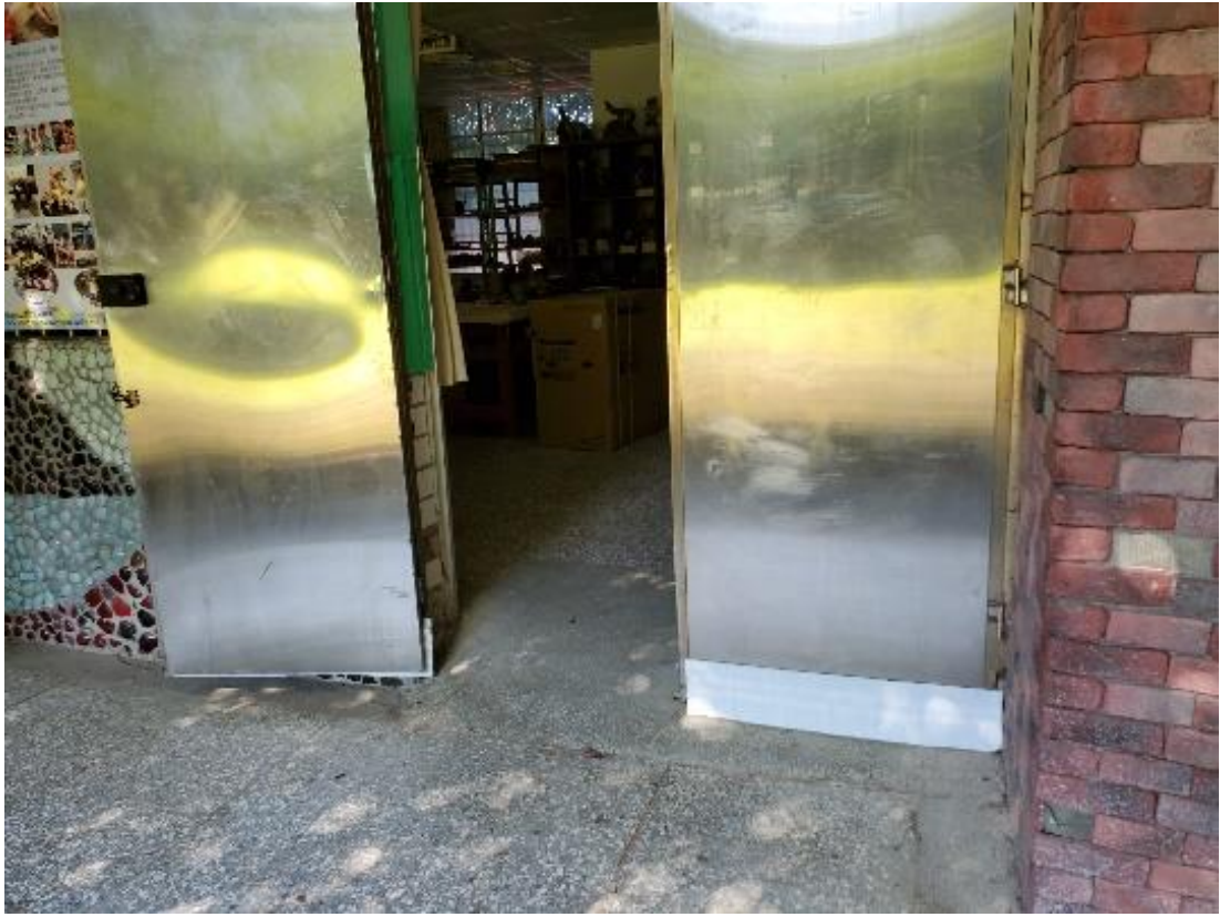
圖14 鶯歌國中辦公室、教室、專科教室門口小斜坡及走廊溝蓋改善 (4/5)
