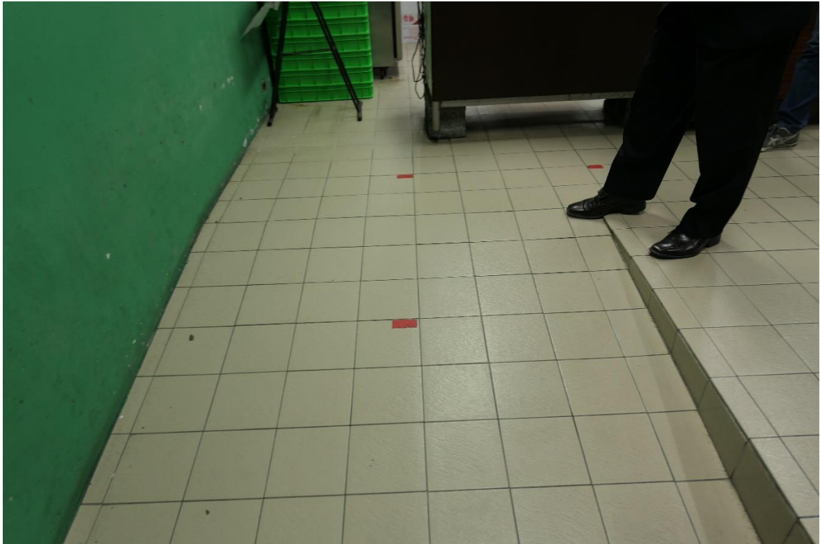
圖11 木柵高工合作社無障礙坡道建置情形
