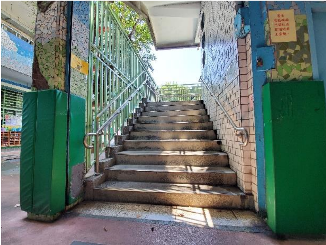
圖8 鶯歌國中各樓梯間設置扶手欄杆 (2/2)
