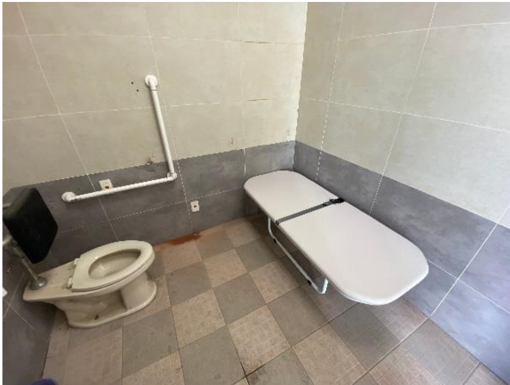
圖25 鶯歌國中特教專用廁所及無障礙廁所（含盥洗盆、照護床、求助鈴）、廁所身障扶手（4/8）
