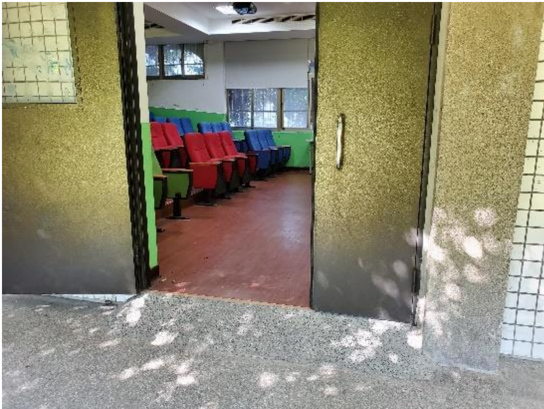
圖13 鶯歌國中辦公室、教室、專科教室門口小斜坡及走廊溝蓋改善 (3/5)
