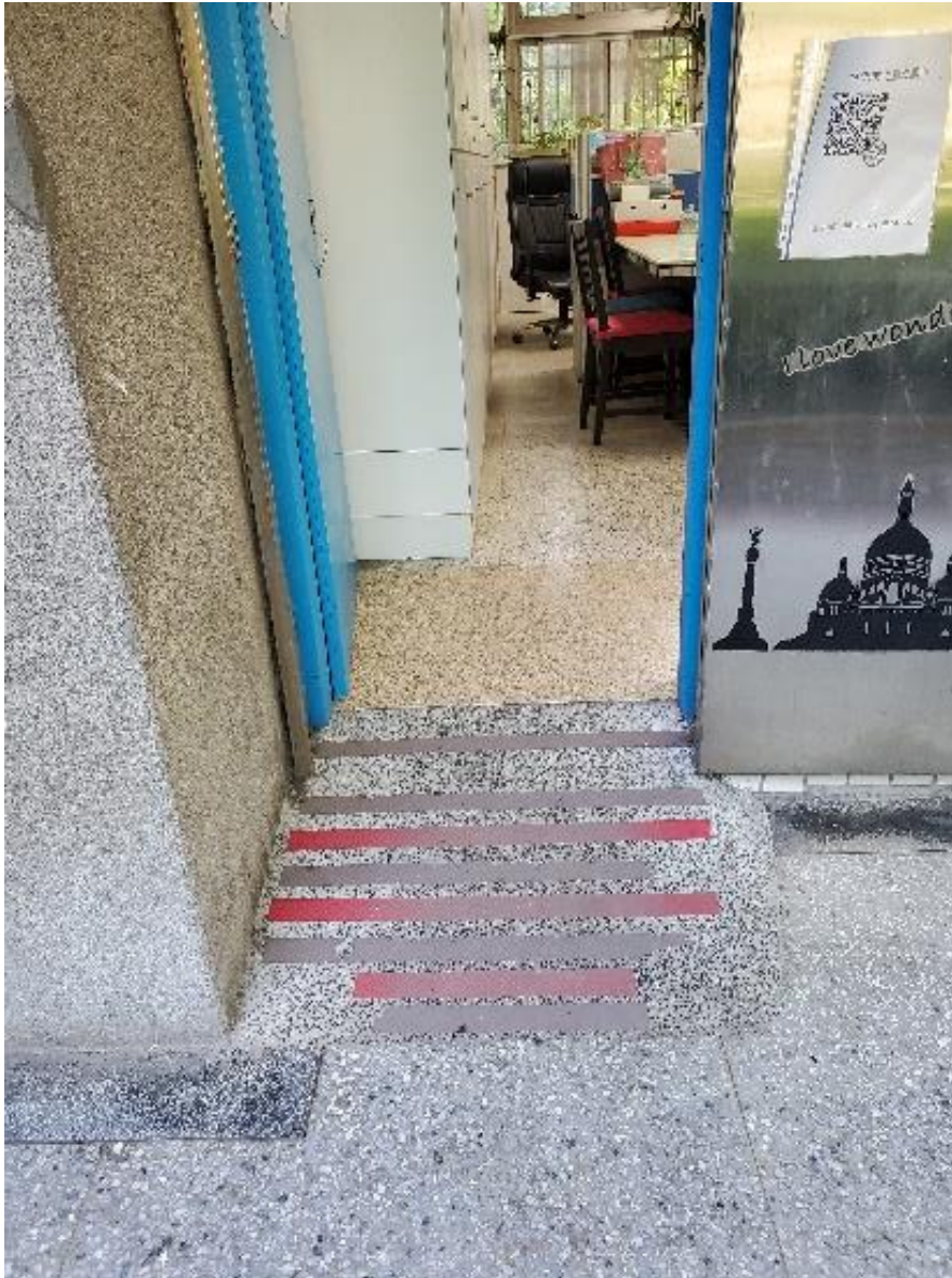
圖11 鶯歌國中辦公室、教室、專科教室門口小斜坡及走廊溝蓋改善 (1/5)
