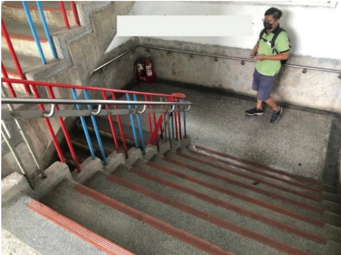
圖7 鶯歌國中各樓梯間設置扶手欄杆 (1/2)
