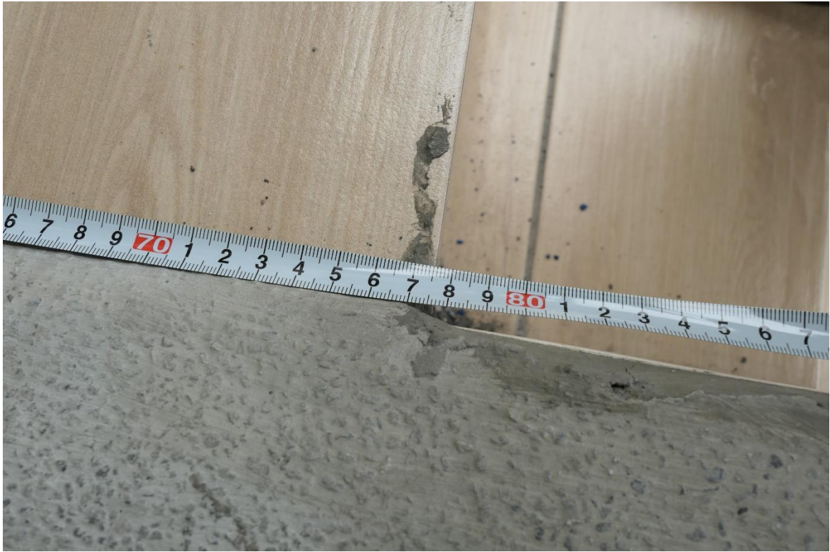
圖7 木柵高工司令臺無障礙設施建置情形（輪椅轉彎處約77.5公分）
