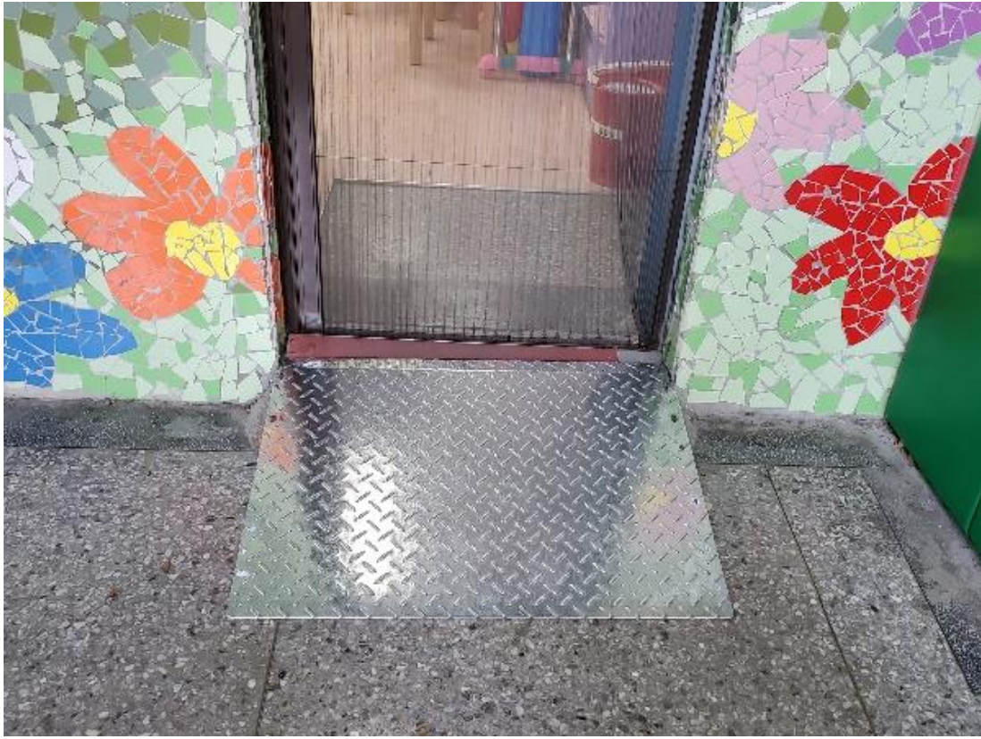
圖10 鶯歌國中活動式鋼製斜坡板 (2/2)
