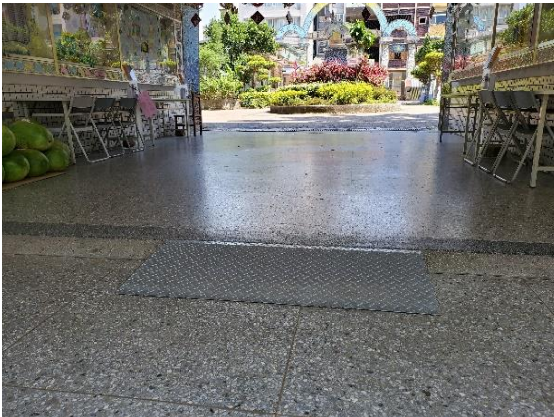
圖9 鶯歌國中活動式鋼製斜坡板 (1/2)
