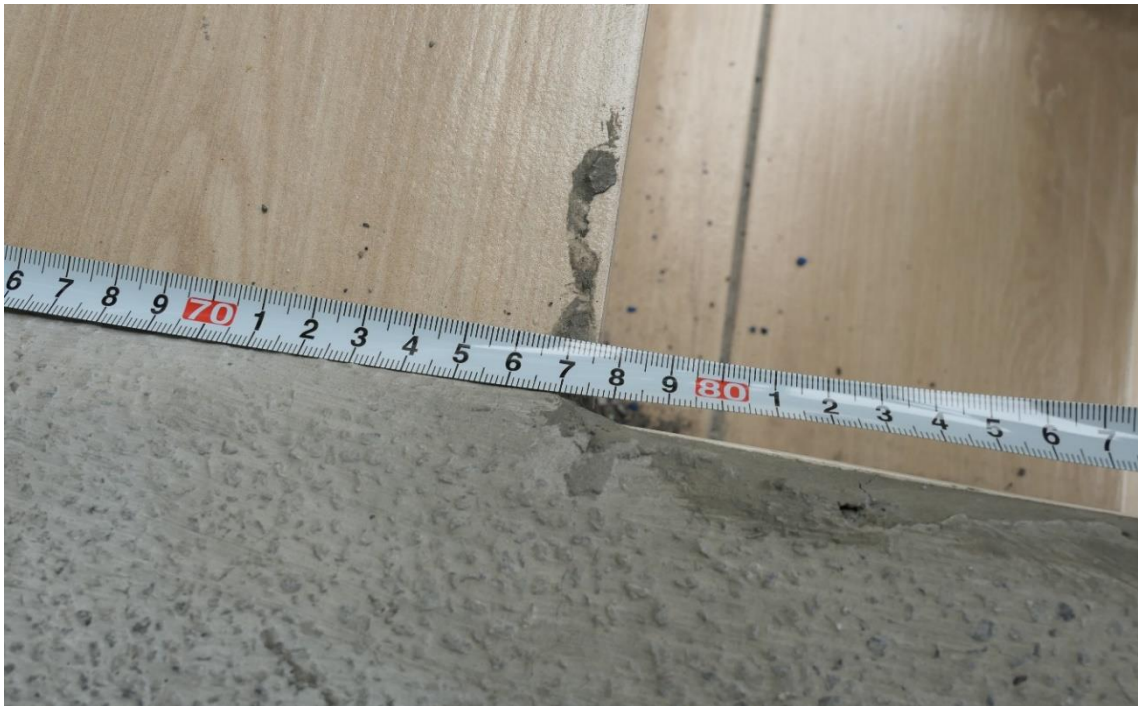
圖8 臺北市木柵高工司令臺無障礙設施建置情形（輪椅轉彎處約77.5公分）
