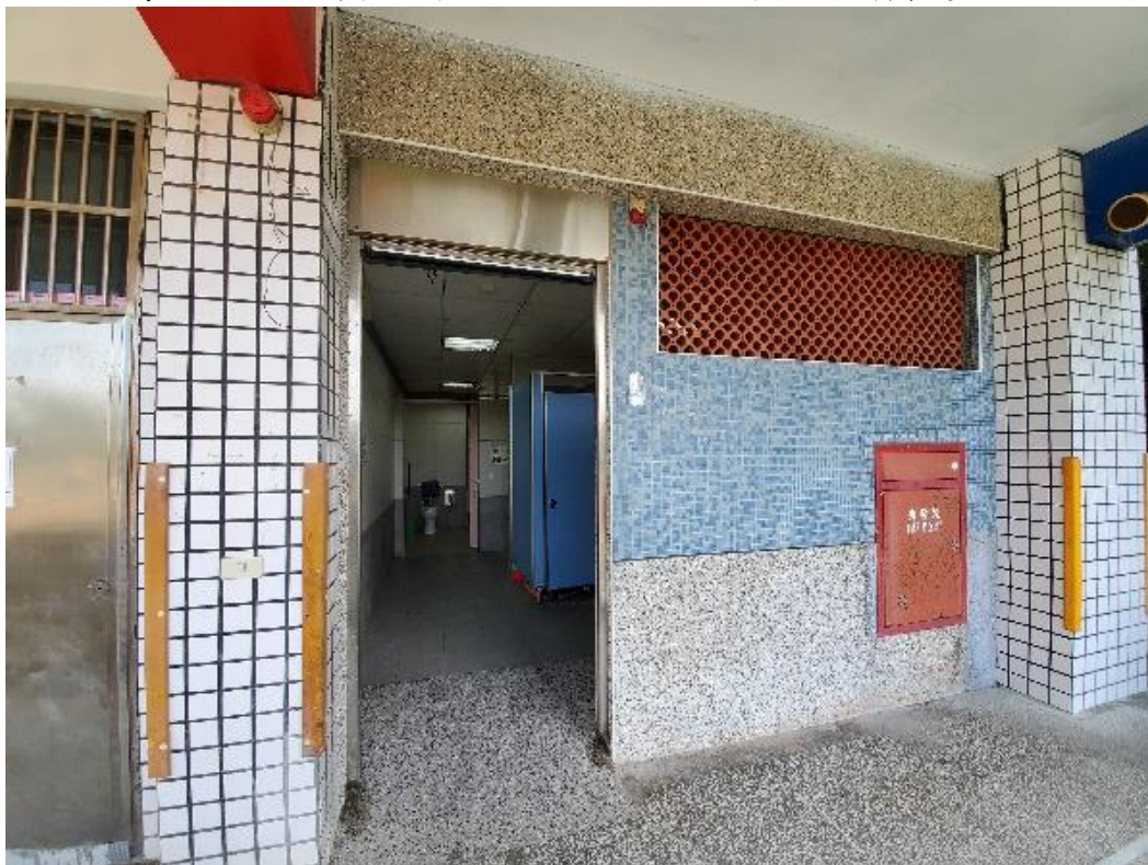
圖22 鶯歌國中特教專用廁所及無障礙廁所 (含盥洗盆、照護床、求助鈴)、廁所身障扶手 (1/8)
