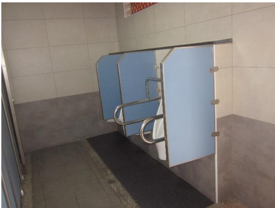
圖29 鶯歌國中特教專用廁所及無障礙廁所（含盥洗盆、照護床、求助鈴）、廁所身障扶手（8/8）
