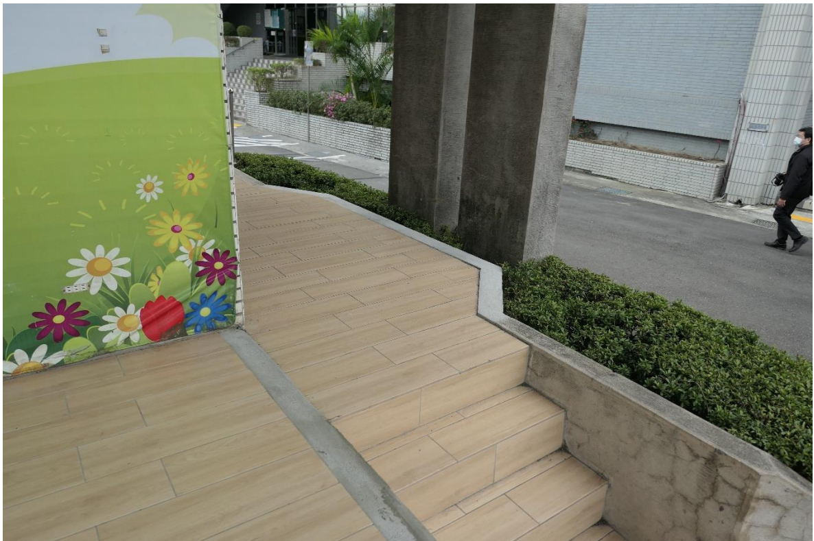
圖6 木柵高工司令臺無障礙輪椅轉彎處
