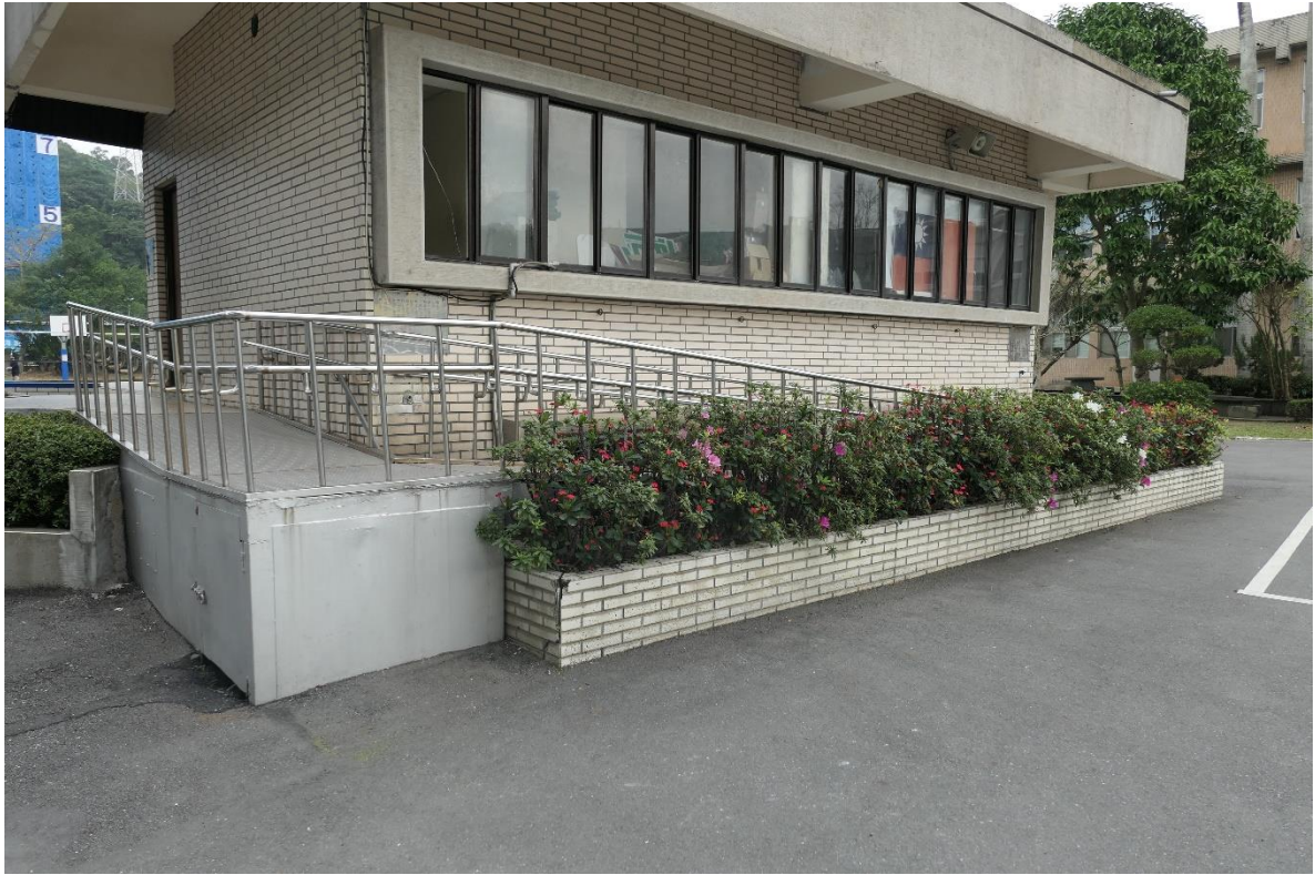
圖5 木柵高工司令臺無障礙坡道建置情形
