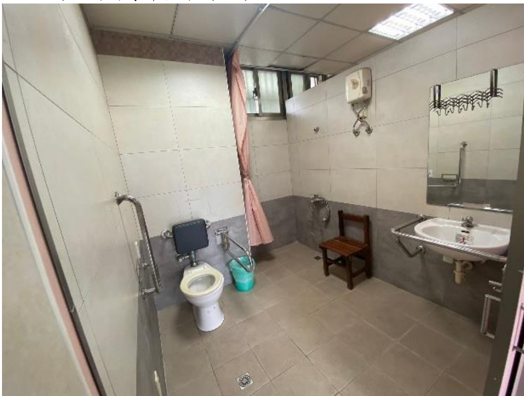
圖28 鶯歌國中特教專用廁所及無障礙廁所（含盥洗盆、照護床、求助鈴）、廁所身障扶手（7/8）
