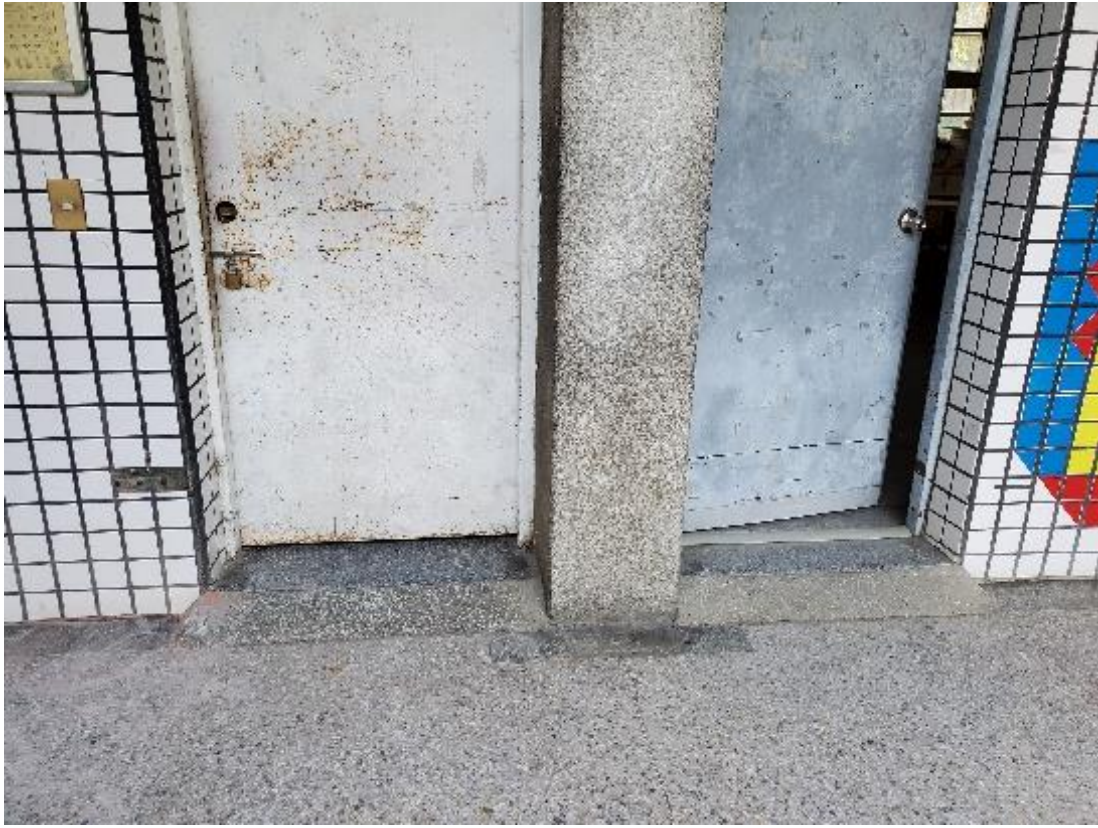
圖12 鶯歌國中辦公室、教室、專科教室門口小斜坡及走廊溝蓋改善 (2/5)
