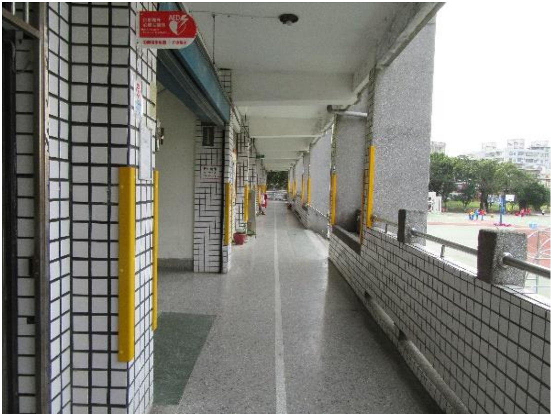
圖19 鶯歌國中1F特教、教室、幼兒園區域樑柱、牆角處設置防撞條 (1/3)
