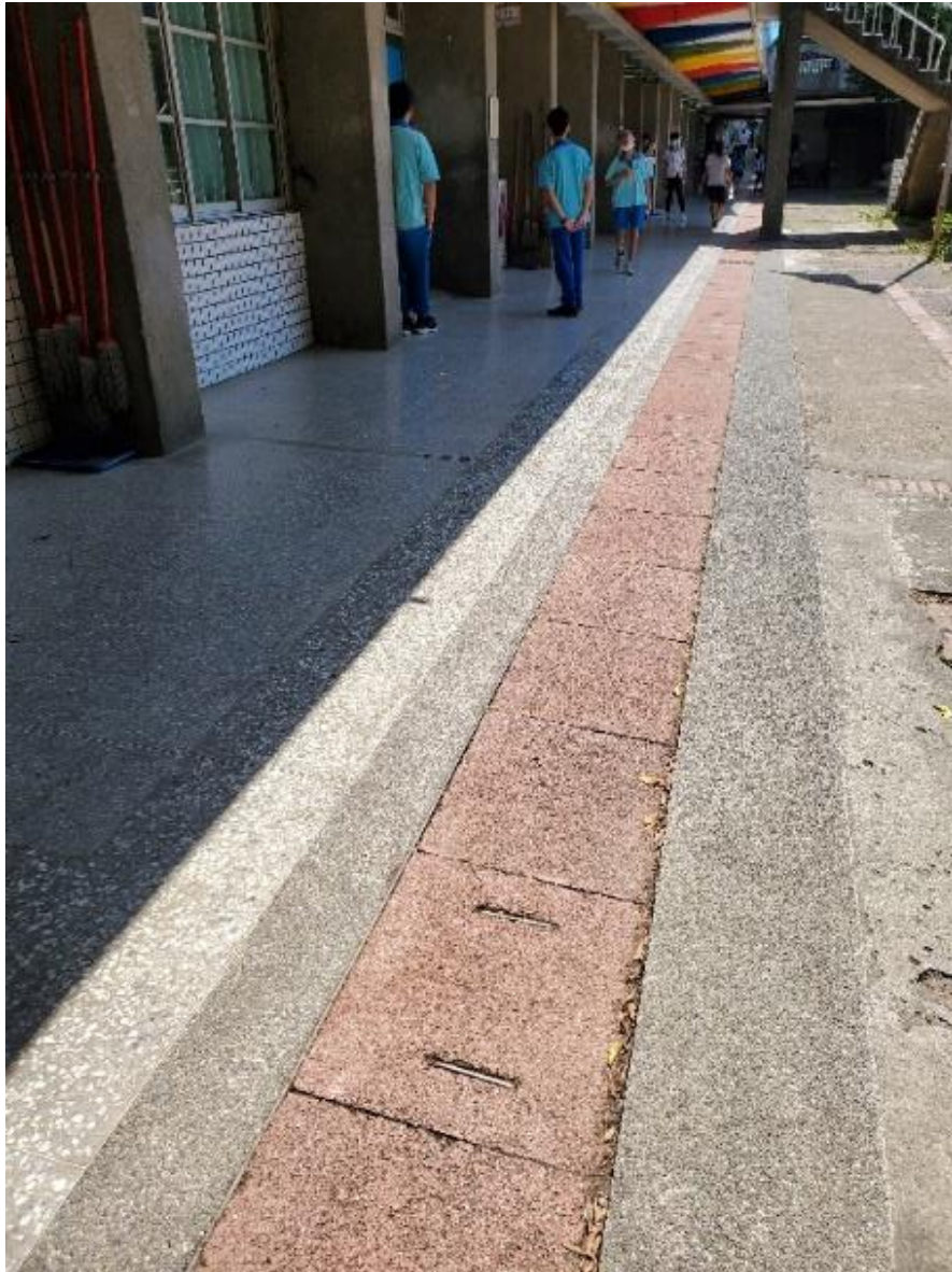
圖15 鶯歌國中辦公室、教室、專科教室門口小斜坡及走廊溝蓋改善 (5/5)
