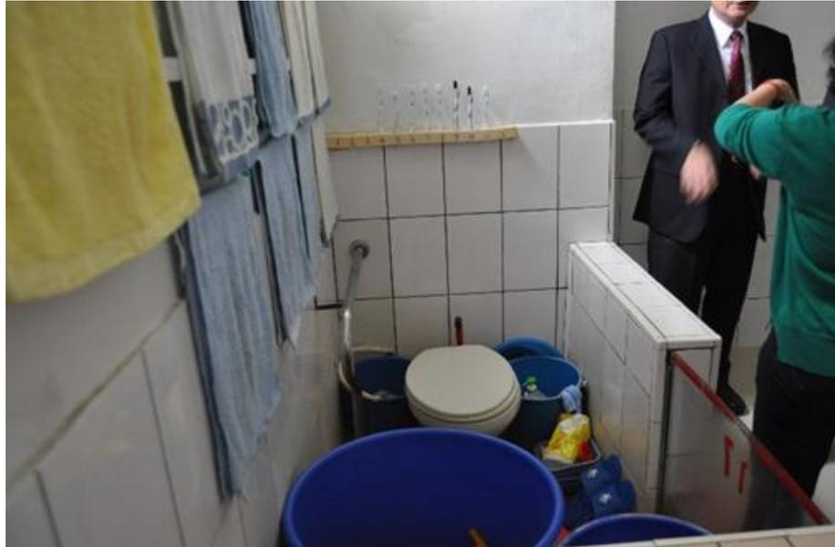
圖12 108年4月12日履勘嘉義監獄無障礙設施（該監身心障礙收容人馬桶僅裝單側扶手）設置情形
