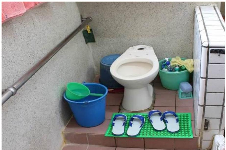
圖11 調查委員履勘雲林第二監獄無障礙設施（舍房坐式馬桶有門檻及無障礙扶手）設置情形
