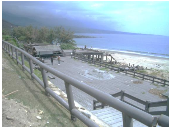
圖3 杉原海水浴場沙灘與路面的高差，原以木作平台方式搭建至沙灘。
