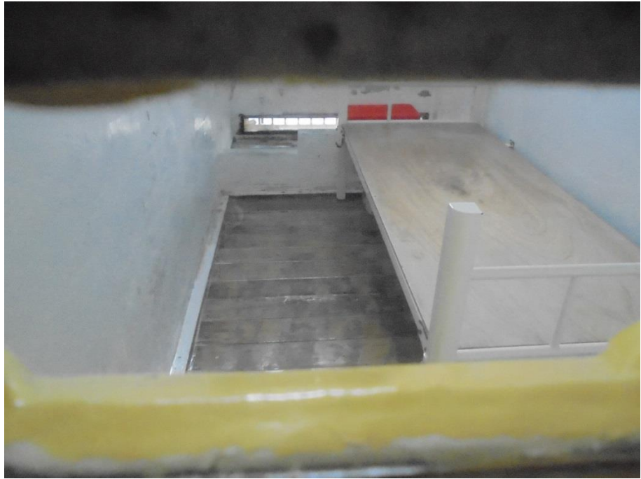
圖15 綠島監獄二東舍80號房瞻視孔照片4（左瞻視孔視角）4
