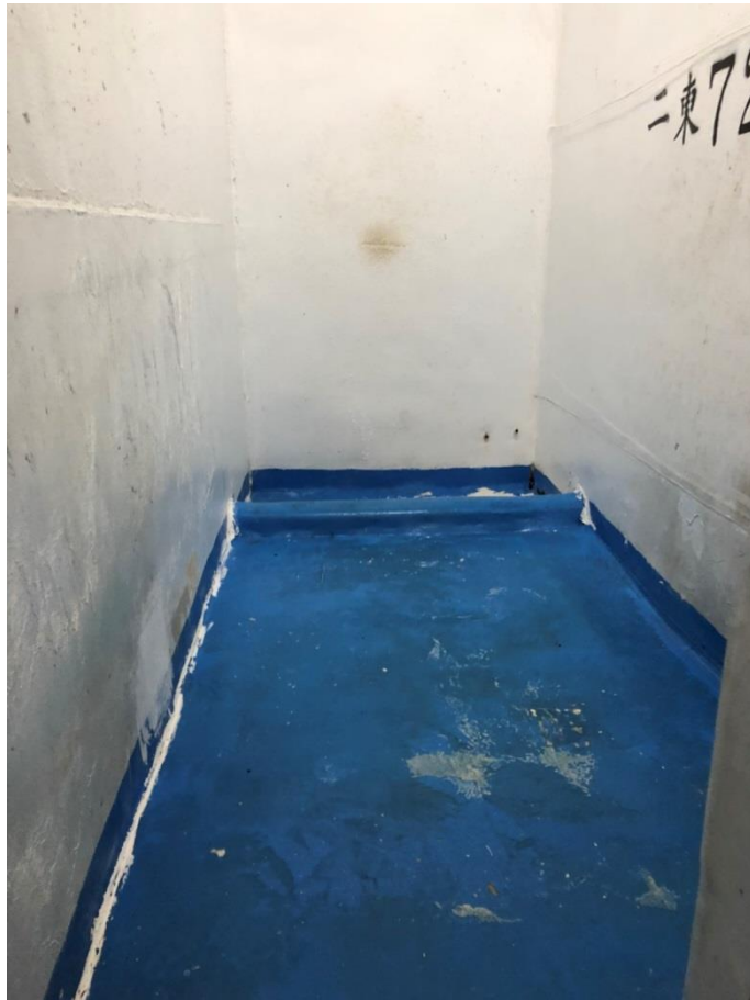
圖29 綠島監獄獨居舍二東舍72號房內部
