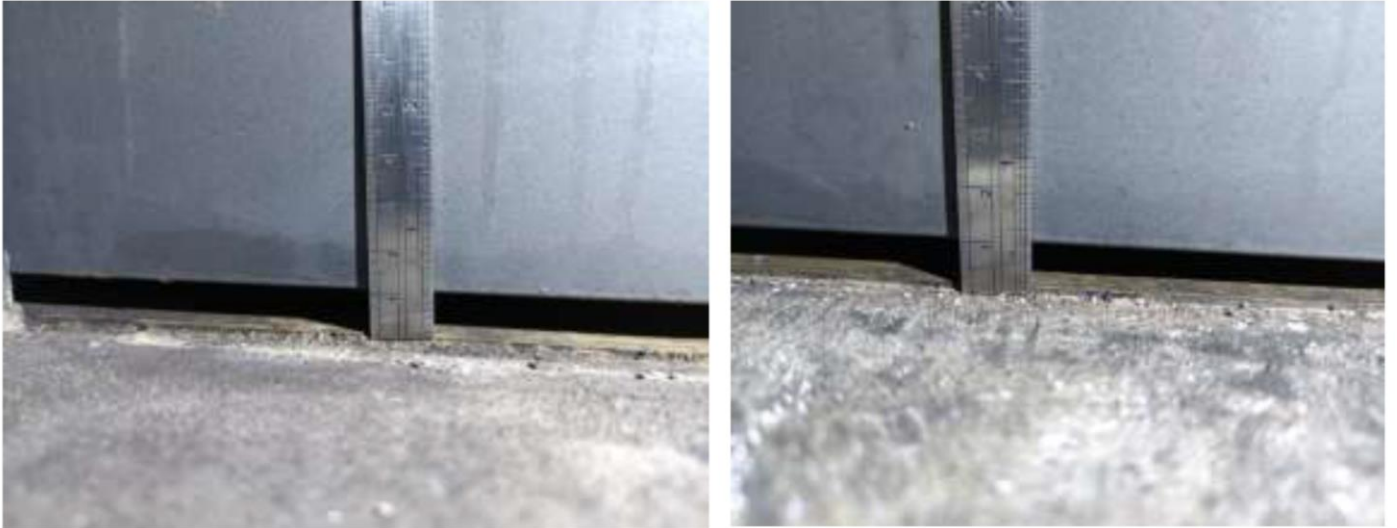
圖5 本事件殉職消防員所在房間管道間及天花板間隙佐證照片
