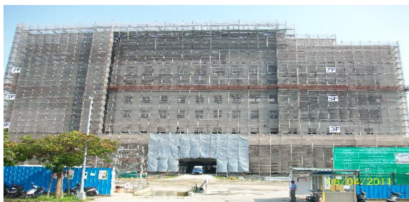
圖1：鳳山地方法院檢察署辦公廳舍新建工程概況 6
