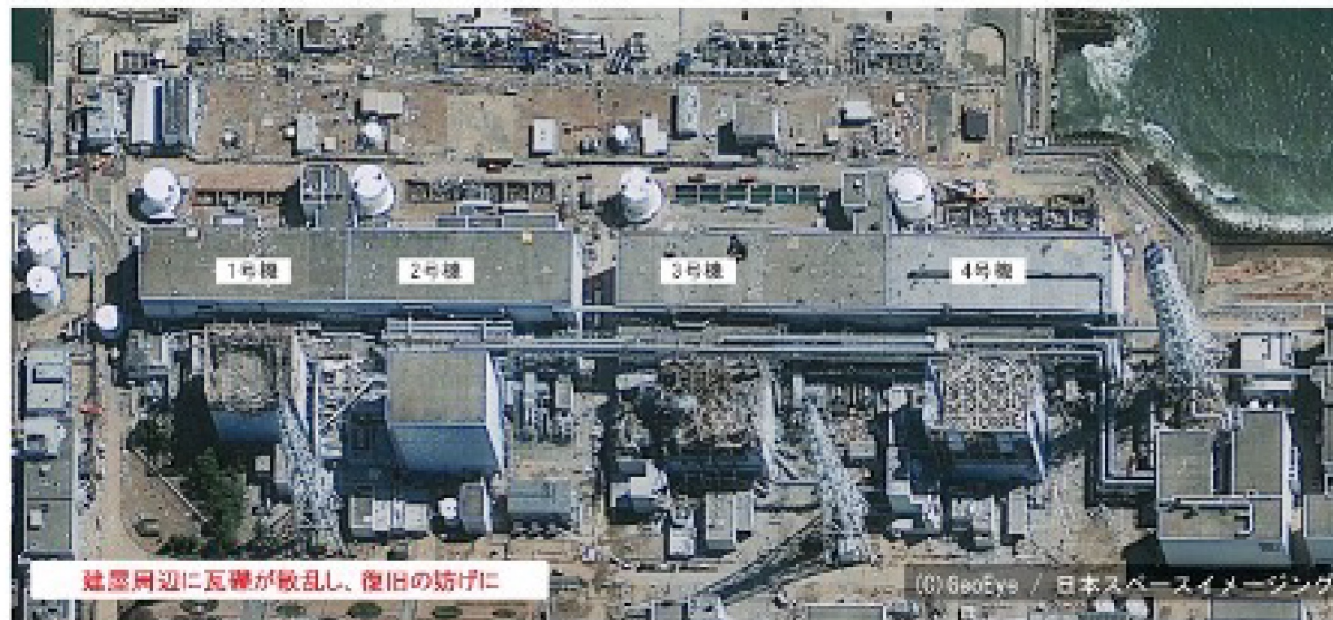
福島第一原子力発電所1~4号機の被害状況 2011年3月19日
