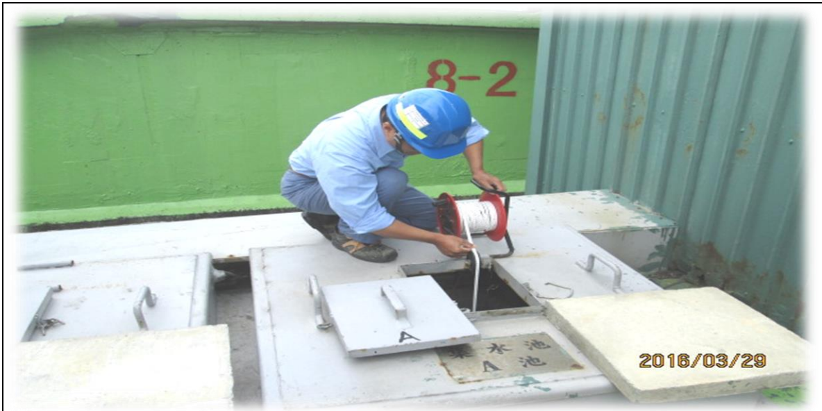
各壕溝定期檢查及量測
