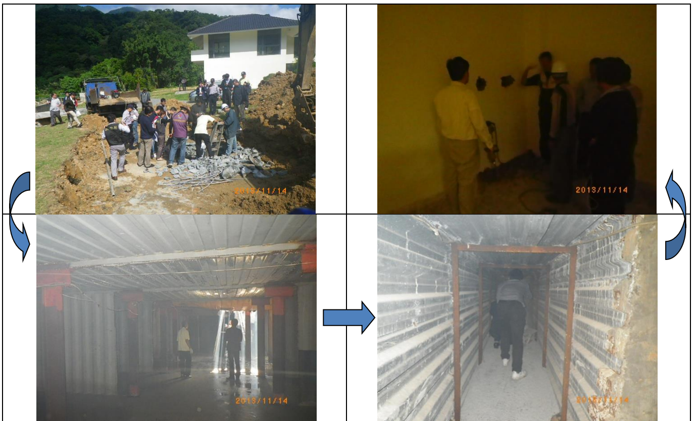
圖 20 本案貨櫃地下室照片
