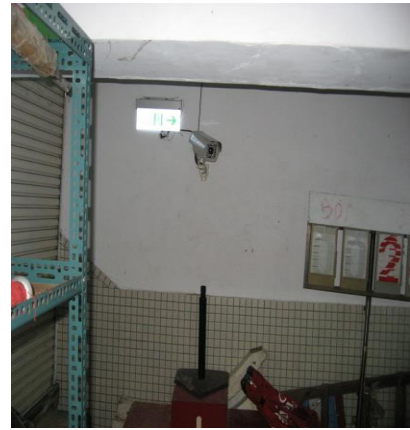
圖 2：事發後， 裝設錄影監視設備。
