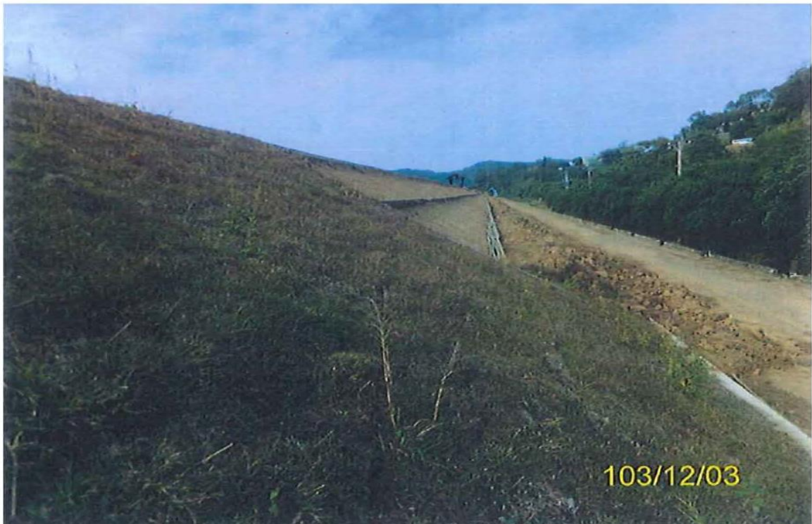
照片4 103年12月3日堤後坡植被土壤滑落后改善情形
