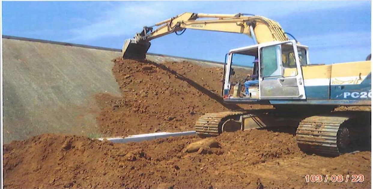
照片1 103年8月23日堤後坡客土鋪設情況
