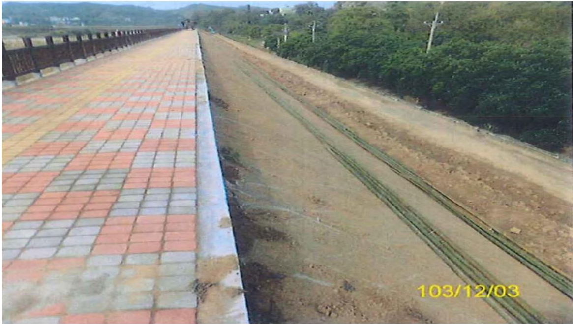
照片3 103年12月3日堤後坡植被土壤滑落后改善情形
