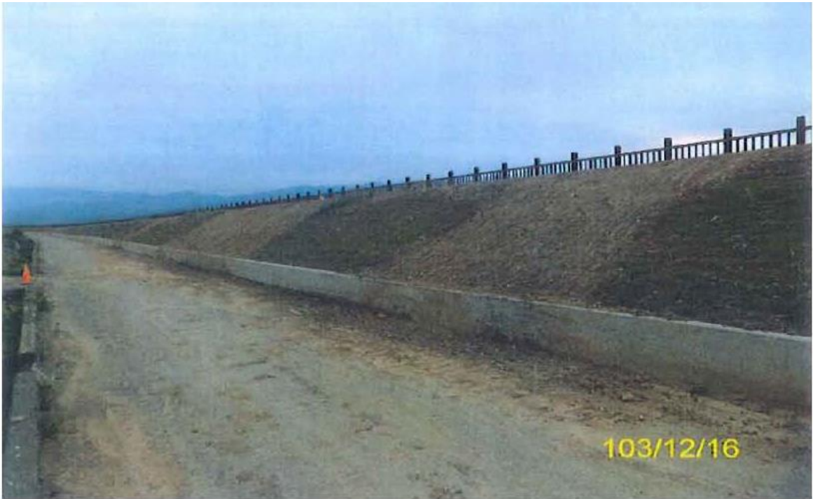
照片5 103年12月16日堤後坡植被土壤滑落后改善情形(尚未鋪設假儉草皮)
