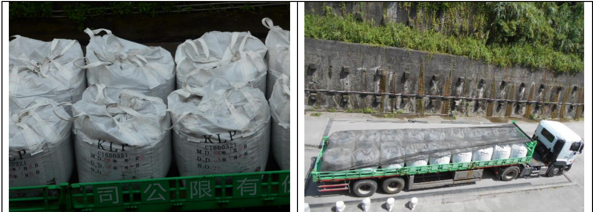
圖6 飛灰穩定化物裝在太空包內及載運車輛加裝防塵網之情形
