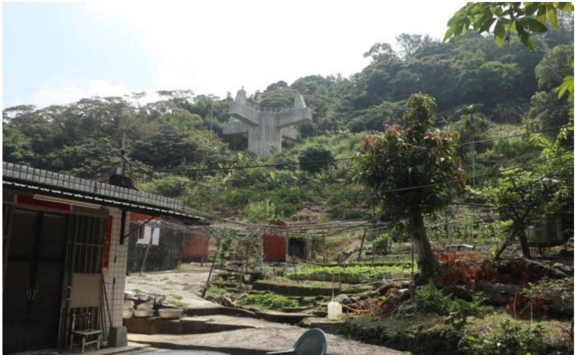
圖5 18號鐵塔塔基外觀，下邊坡鄰近指南宮步道旁的民宅
