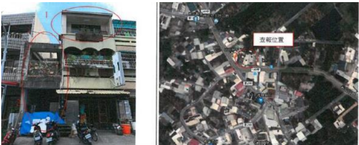
古坑鄉公所108年11月4日違建查報通知單。1. 頂樓增建、2. 空地增建。 施工完成程度100%。
