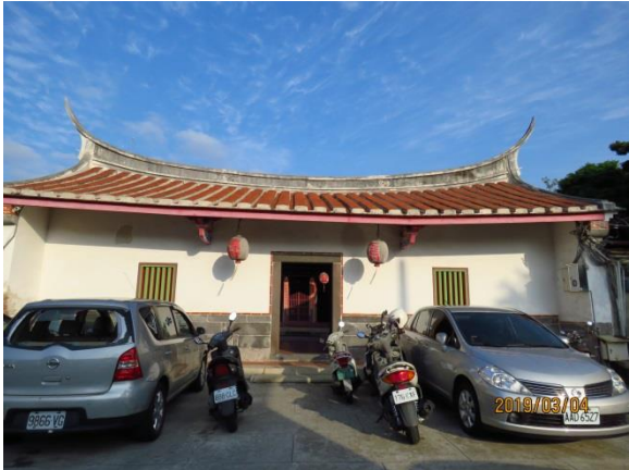
照片 1、古蹟原貌遭變更，屋脊粘黏消失不見(左)、窗戶型式變更且封閉(右)
