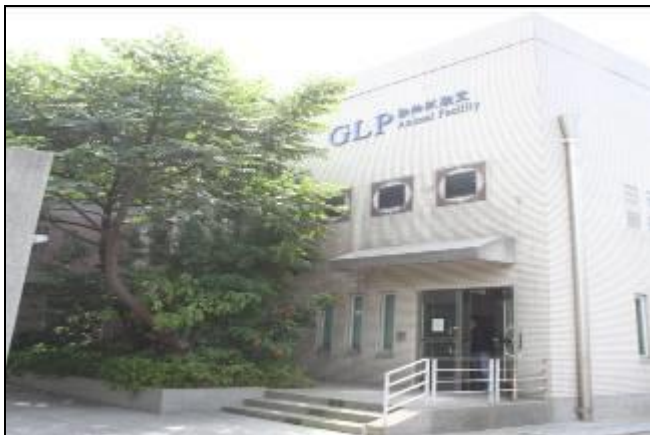
GLP 實驗室外觀
