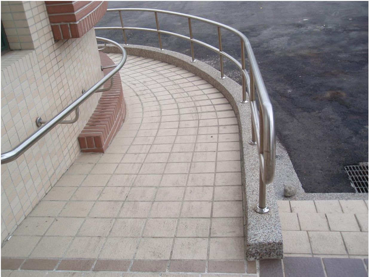
附圖十一、社頭鄉產業發展推廣中心之「無障礙坡道」-由核准之「粗面窯燒花崗磚」擅自變更為「石英磚」
