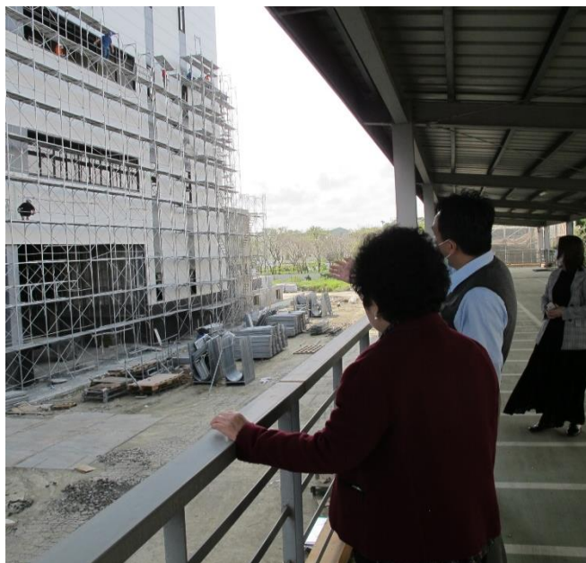
H公司主管人員說明該公司興建廠房進度。
