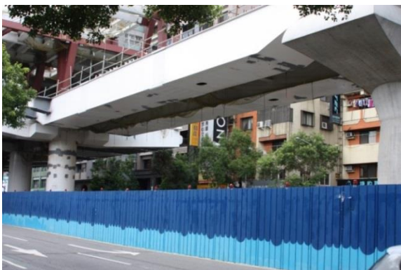
(a)臺中捷運綠線工程 G6 站 工區外觀
