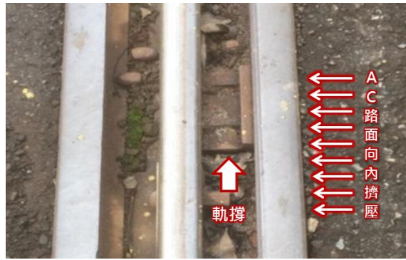
圖14 AC路面受地形因素向內擠壓外側護軌
