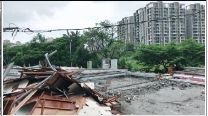
圖6 新北市政府續拆除未完成部分
