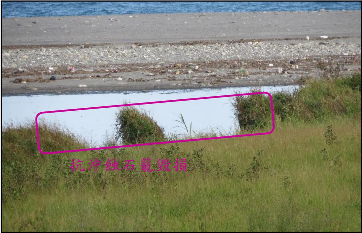
圖5 104年10月1日本場生態池抗沖蝕石籠毀損（資料來源：臺東縣審計室。）
